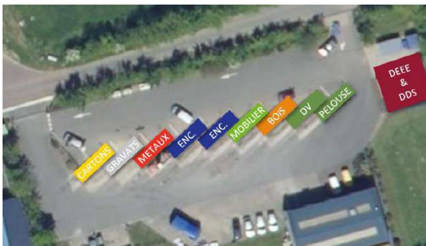
Figure 2 : Vue aérienne de la déchetterie communautaire de La Haye. Y sont visibles les 9 quais où sont positionnées 9 bennes de 20 à 30m 3 , le local ouvert pour DEEE et DDS (toit gris à droite), le local fermé pour DDS (toit blanc à droite), le bureau du gardien de déchetterie (toit bleuté en haut à droite) et la benne d'amiante de 15m 3 (en bas à droite).
