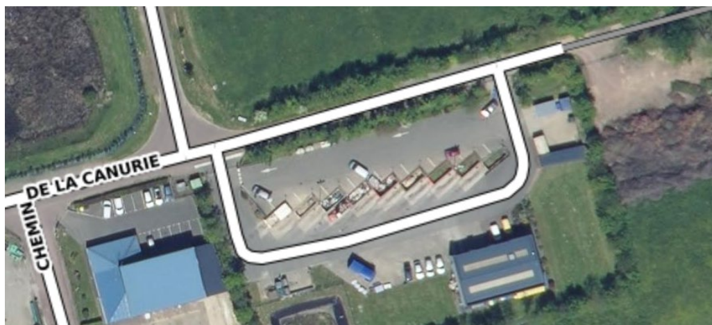
Figure 2 : Vue aérienne de la déchetterie communautaire de La Haye. Y sont visibles les 9 quais où sont positionnées 9 bennes de 20 à 30m 3 , le local ouvert pour DEEE et DDS (toit gris à droite), le local fermé pour DDS (toit blanc à droite), le bureau du gardien de déchetterie (toit bleuté en haut à droite) et la benne d’amiante de 15m 3 (en bas à droite).
